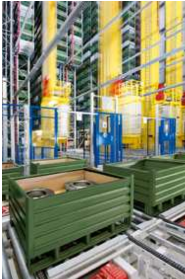
Blick auf die Vorzone der weitverzweigten Palettenfördertechnik
