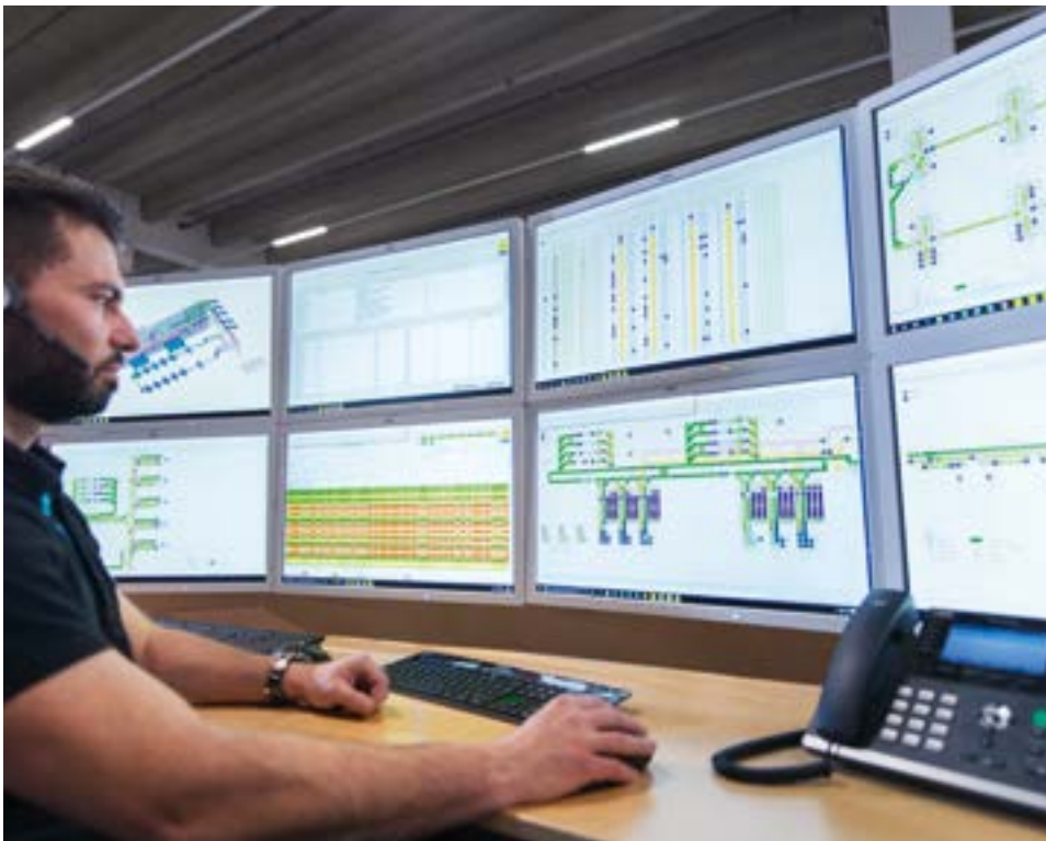
← Poste de contrôle avec psb selektron WMS et selektron SCADA pour le contrôle et la surveillance du système intralogistique
